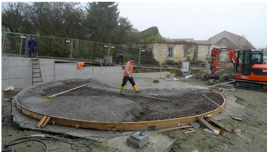
Nicole Six und Paul Petritsch, Feuerstelle Ortszentrum Klein-Meiseldorf (Baustelle) © Bildrecht 2020
